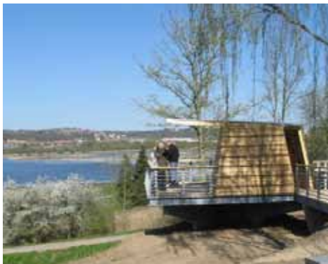
Udsigtspunkt ved Kongens Kær
